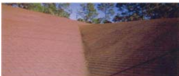
塗布側（左側）は完全にカビ・汚れなどを抑制していることが目視で確認できます。 （この写真は塗布してから、約5年後に撮影されたもの）
